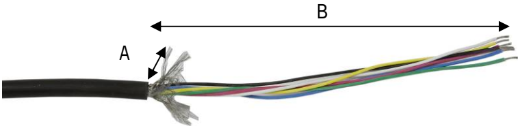
Figura 2-38: preparazione del cavo della cella di carico
