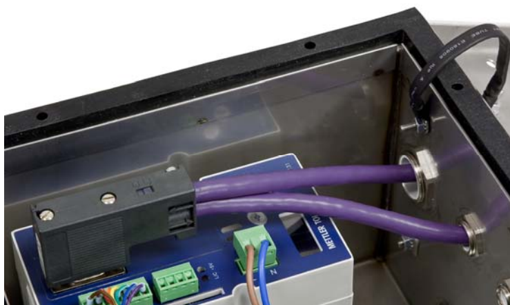
Figura 2-63: Colocación del cable PROFIBUS en el gabinete para caja de conexiones, versión actualizada
