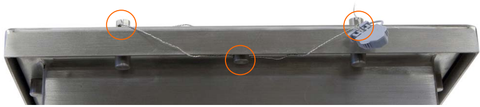
Abbildung 2-79: Versiegeln der Aktualisierte Abzweigkastenversion – Versiegelungsstifte und -schrauben
